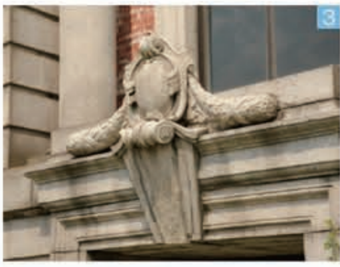
■ 雰囲気たっぷりの旧第一ポンプ所 ■ 赤レンガの壁に白い石材をあしらって開口部を強調したデザインは、19世紀イギリスのクイーン・アン様式で。旧第一ポンプ所は、市の有形文化財に指定
