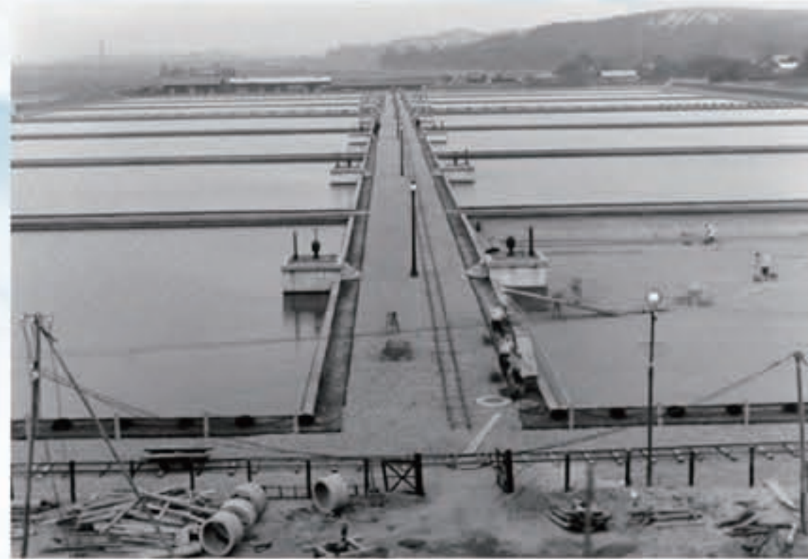
上) 自然生物の浄化作用を利用した緩速ろ過池。創設当時は8池が造られました 下) 昭和初期、緩速ろ過池が14池に増設された様子
