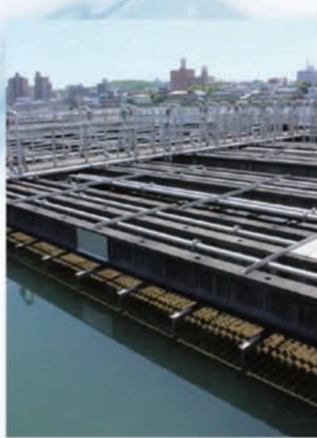
水中の濁りなどが沈んでいく過程がわかる、急速系の凝集沈殿池。ジグザグな造りになっているのは、水の流れを複雑にして薬品でより大きな汚れのかたまりにして沈んでさせるため
