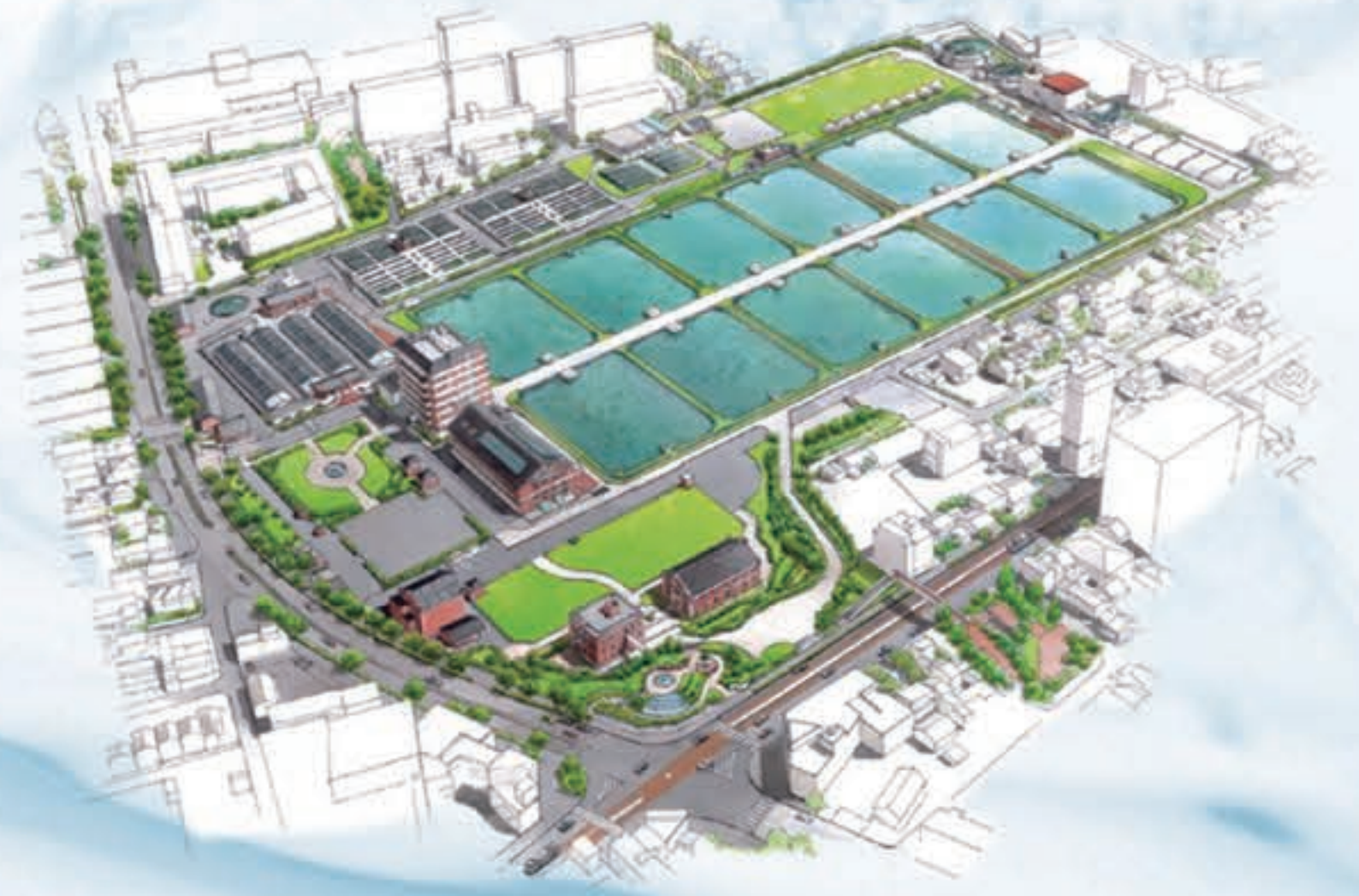
24時間体制で稼働する鍋屋上野浄水場。市内各所にある配水場・ポンプ場についてもコンピューターで集中管理し、配水池の貯水量や配水圧の調整をしています
